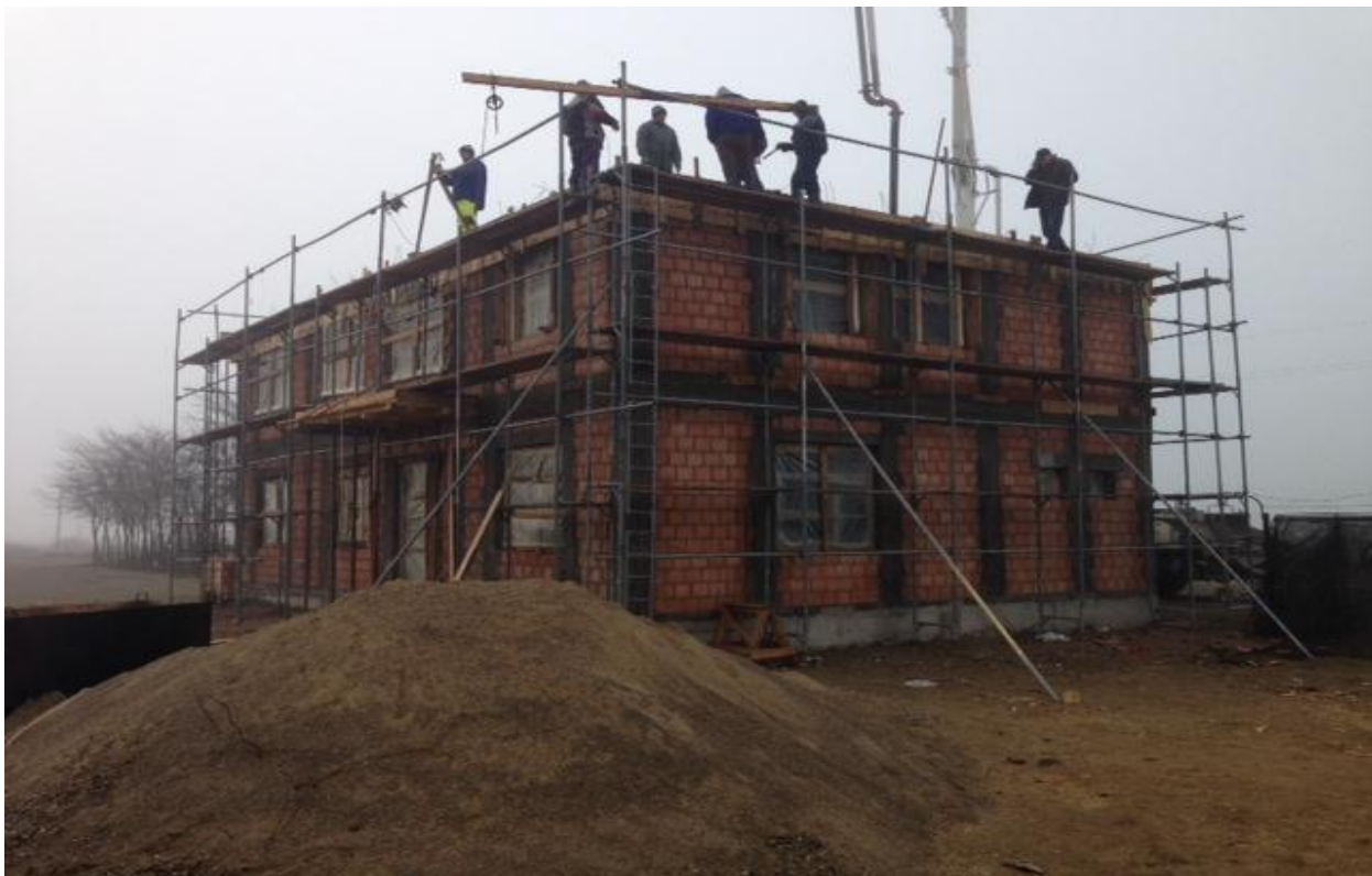
Byggeri af kontorbygning ved site i Østrumænien
